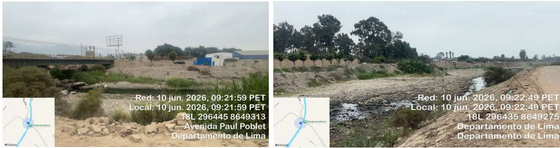
FOTOGRAFIAS DE AMBAS MARGENES DEL RIO LURIN EN EL SECTOR QUEBRADA VERDE
